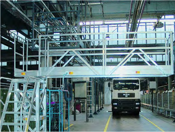
Aluminium vast opgesteld wegdraaibaar werkplatform met toegangstrap.
