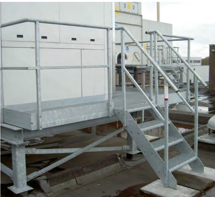
Aluminium vast opgestelde brugtrap, 2-zijdig begaanbaar.
