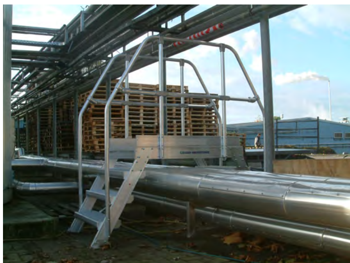
Aluminium vast opgestelde brugtrap met open rooster, 2-zijdig begaanbaar.
