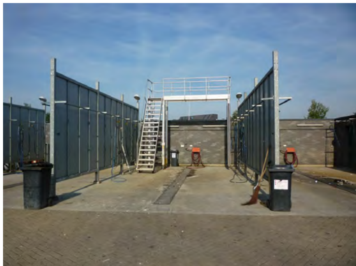
Aluminium verrijdbaar in hoogte verstelbare portaalconstructie.
