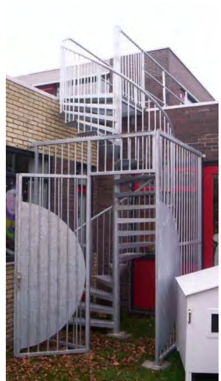
Stalen spiltrap met beveiligingsdeur en kooi.
