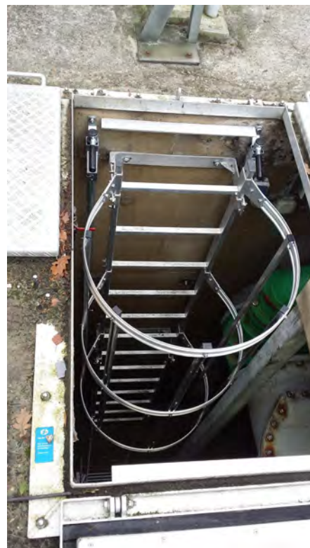
Kooiladder binnenin een onderhoudsgemaal
