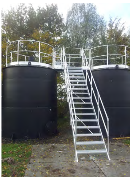
Vaste bordestrap met toegangspoort en dubbelzijdige werkbordessen
