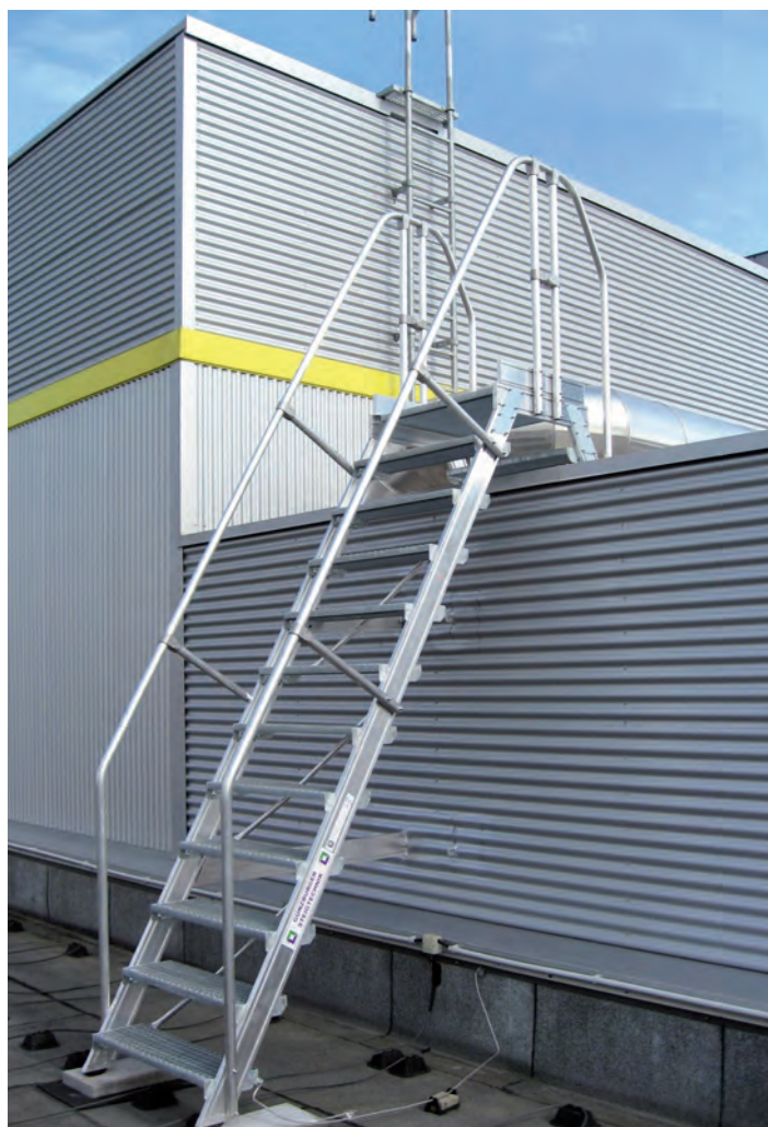
Brugtrap op het dak met betonsloffen.
