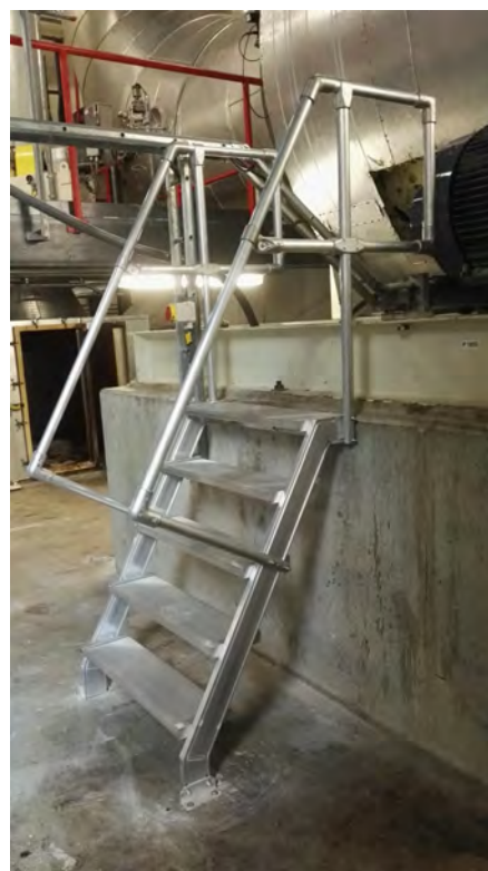
Vaste trap met dubbelzijdig leuningwerk
