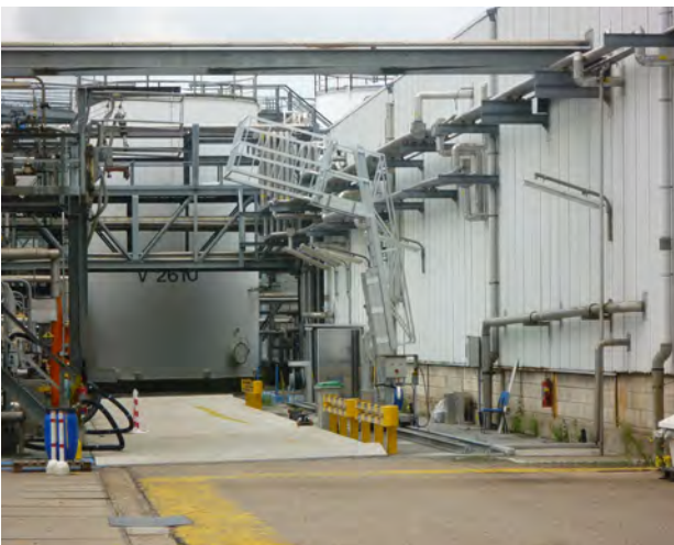
Aluminium elektrisch op rails verrijdbare, verstelbare tankwagenladder. Onderzijde veiligheidskorf voorzien van rubberen stootrand.
