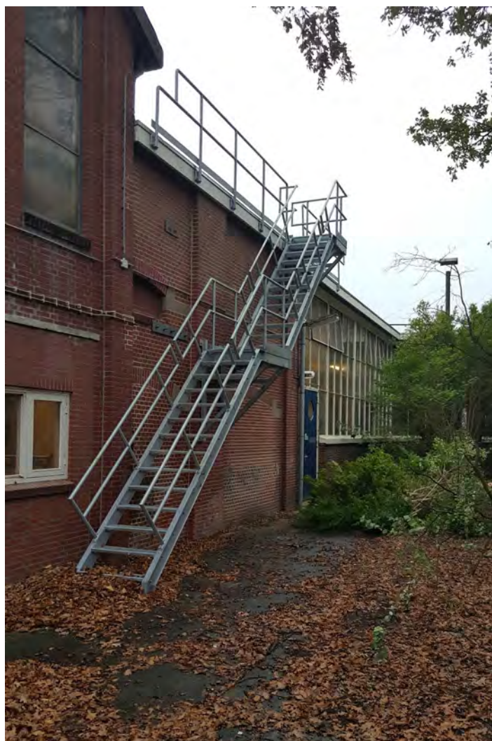
Staalverzinkte steektrap met inloopbeveiliging en volledig leuningwerk.
