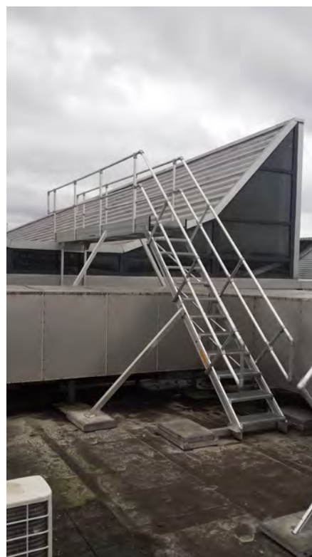
Vaste bordestrap met staal verzinkte roostertreden
