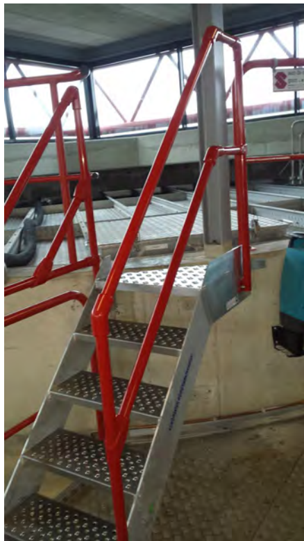
Vaste trap met rood RAL-gecoat leuningwerk
