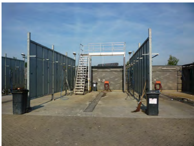
Aluminium portaalconstructie met toegangstrap.
