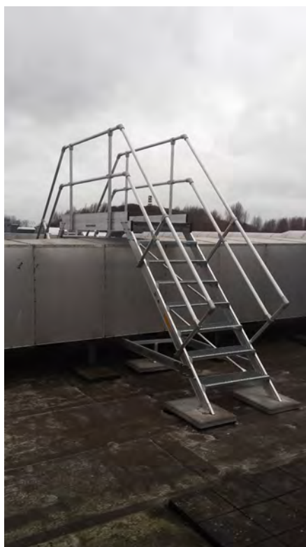
Brugtrap met staal verzinkte roostertreden
